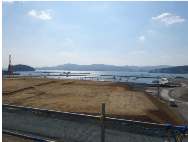
災害現場の盛土工事、1ヶ月の測量を1週間で実施
